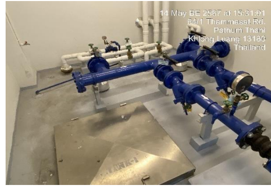
ภาพที่ 2-13 ระบบใช้น้ำ และการตรวจสอบประจำวัน
